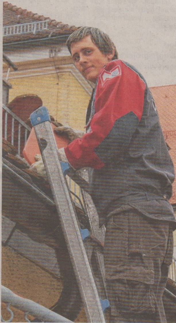
Der Erdöl- und Erdgasproduzent RWE Dea kann strukturbedingt nicht soviel ausbilden, wie der Konzern gerne würde und übernimmt deswegen die Lohnkosten für Lehrlinge, hier der angehende Dachdecker Michael Maetzing.
